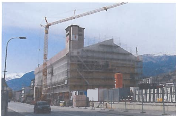
➤ Les travaux du Campus sont en cours © Gilles Vouillamoz (Tiré du fonds des archives municipales)
